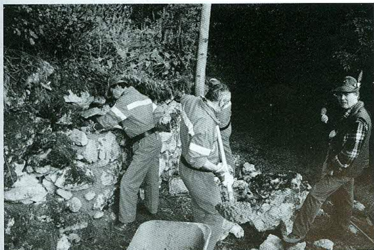
Sistemazione di un muro di sostegno
