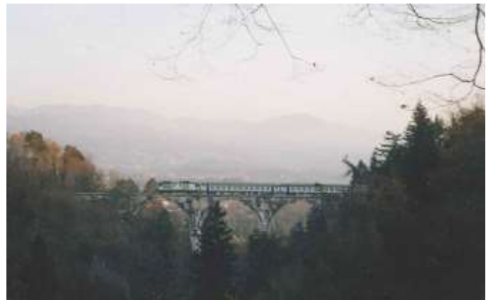
Il ponte ferroviario di Val di Siva, visto dal parco di Villa Pagani-Gaggia a Socchieva di San Fermo
