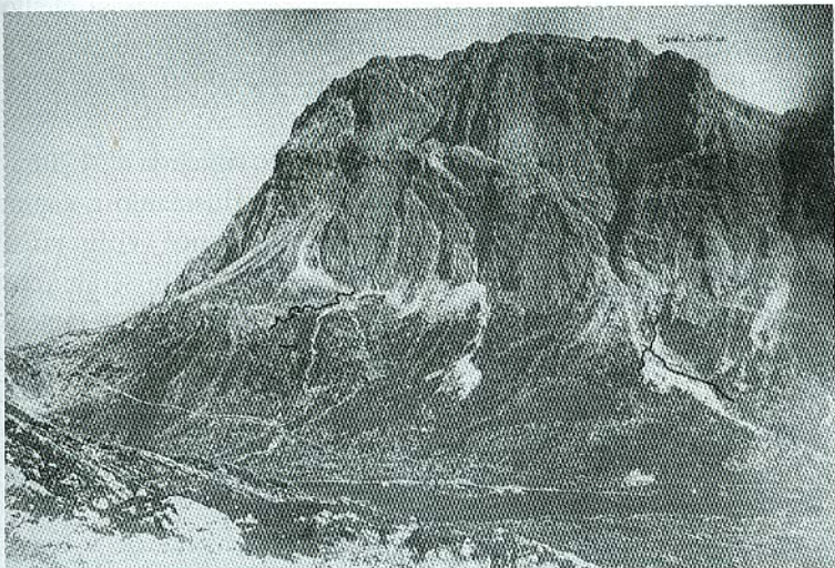
Fotografia del Piccolo Lagazuoi presa dal Col Gallina, prima delle esplosioni. Sono evidenziate le trincee austriache e italiane
